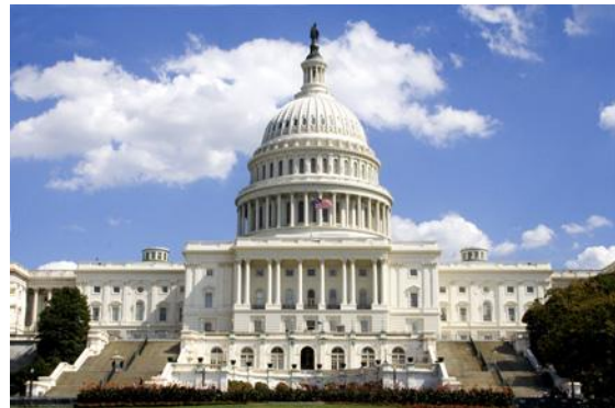
El Capitolio de Washington (W. THORNTON; B. LATROBE; CH. BULFINCH).
